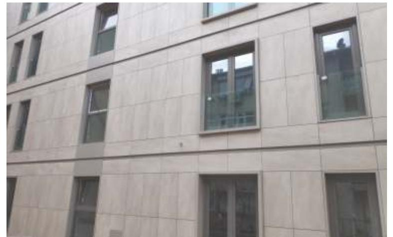
Diş cepheye uygun özel olarak üretilen granit seramik cephe sistemi, yıllardır çeşitli alt konstrüksiyon seçenekleriyle uygulanmaktadır.
